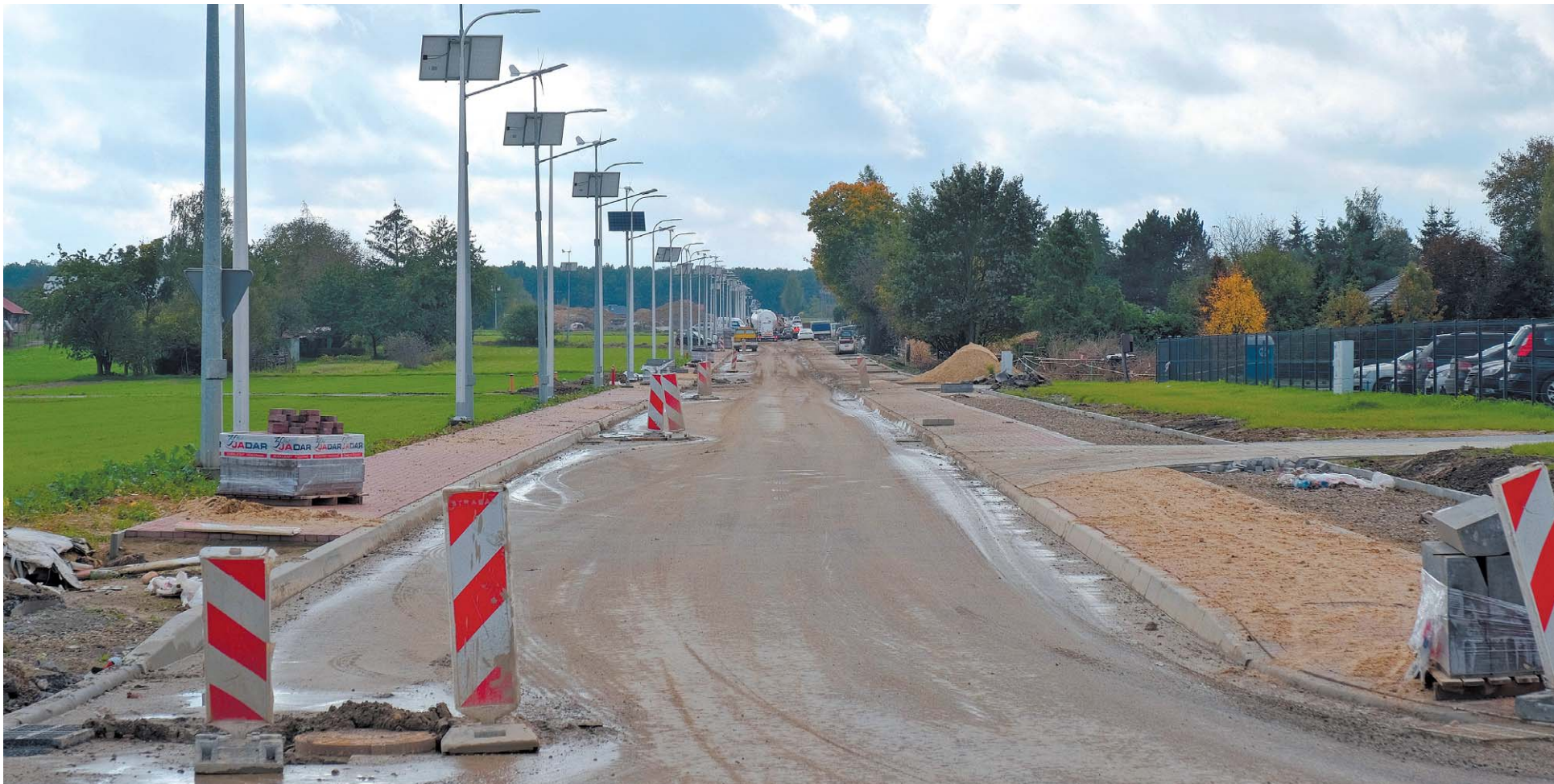
Po zakończeniu prac na ul. Nadleśnej miasto chce przystąpić do realizacji bocznych dróg
