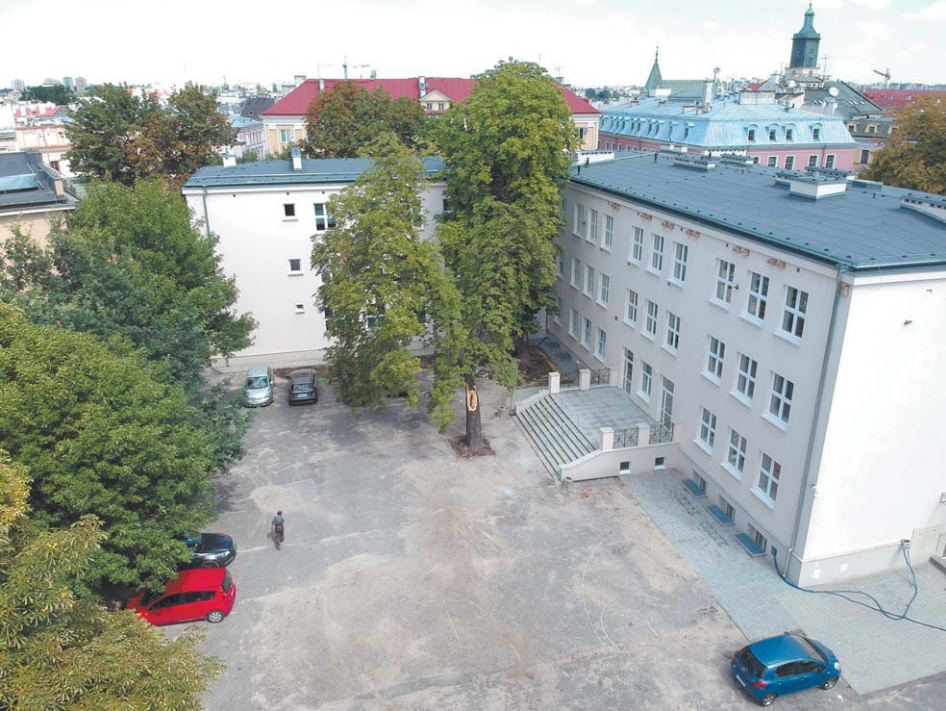
Sala gimnastyczna dla III LO im. Unii Lubelskiej miała powstać na tyłach szkoły, ale... pod ziemią
