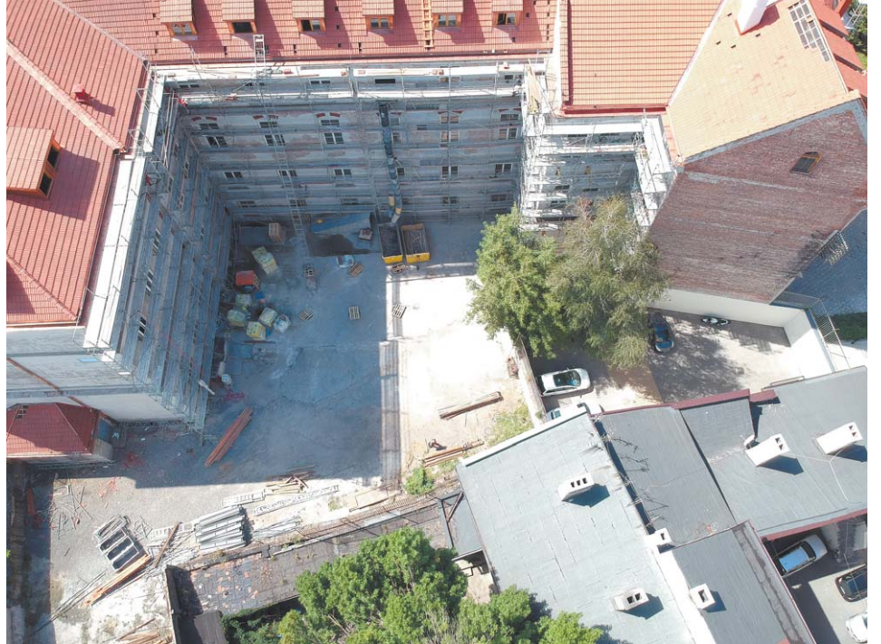
Trwa remont szkół im. Vetterów przy ul. Bernardyńskiej. Na tyłach gmachu planowana jest sala gimnastyczna
