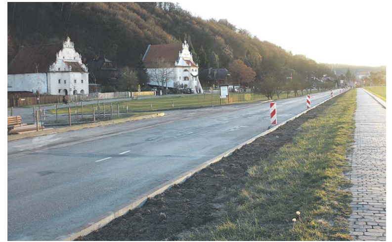
Jedną z ważniejszych inwestycji drogowych jest planowana przebudowa odcinka drogi powiatowej z Bochojnic do Kazimierza Dolnego
