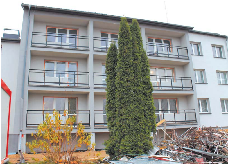
Budynek po szkole zdobi już nowa, szara elewacja. Cały obiekt został ocieplony i wyposażony w nowe instalacje, w tym ogrzewanie gazowe
