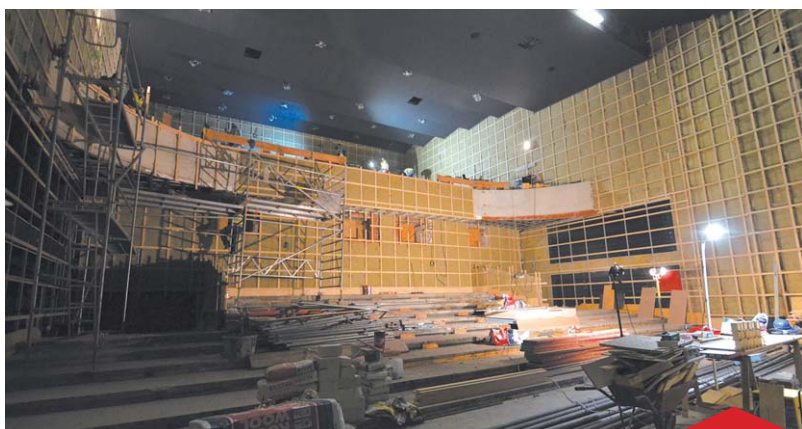
Sala widowiskowa w remoncie
