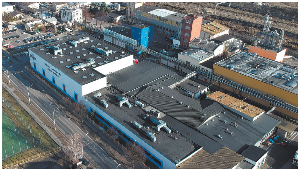
Gorzelnia zajmie ok. 10 proc. terenu zakładu przy Krochmalnej
