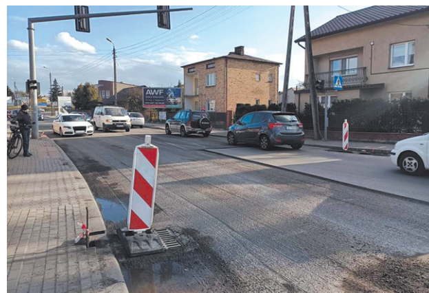
Na skrzyżowaniu Witoroskiej i Łomaskiej powstaje rondo
