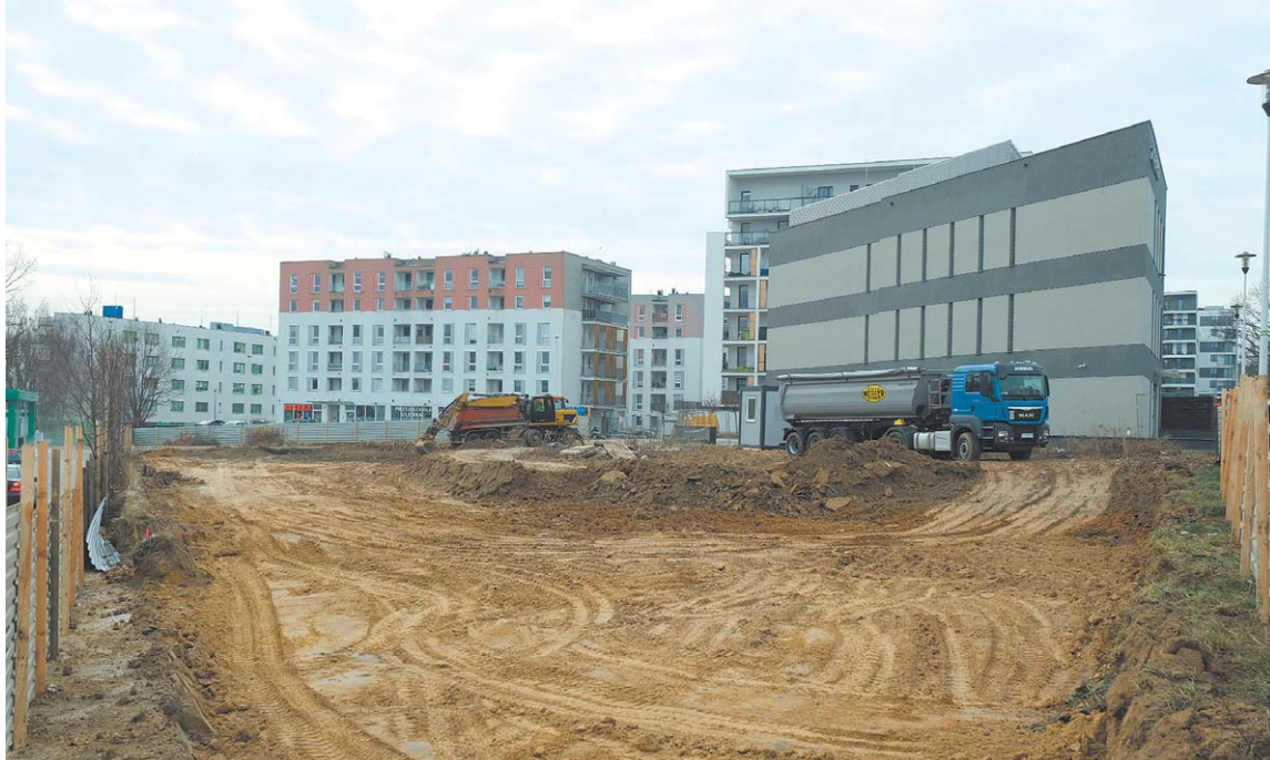
Na placu budowy powstaje już wykop pod fundamenty przyszłego budynku
