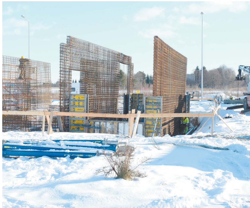
Budowa stacji tankowania wodoru przy ul. Grygowej w Lublinie. Stacja ma być gotowa w czerwcu
