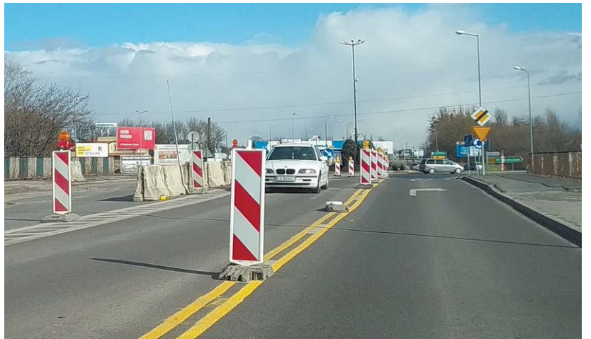
Ul. Rejowiecka. Budowa, która kosztuje ponad 100 milionów złotych, ma się zakończyć za dwa lata
