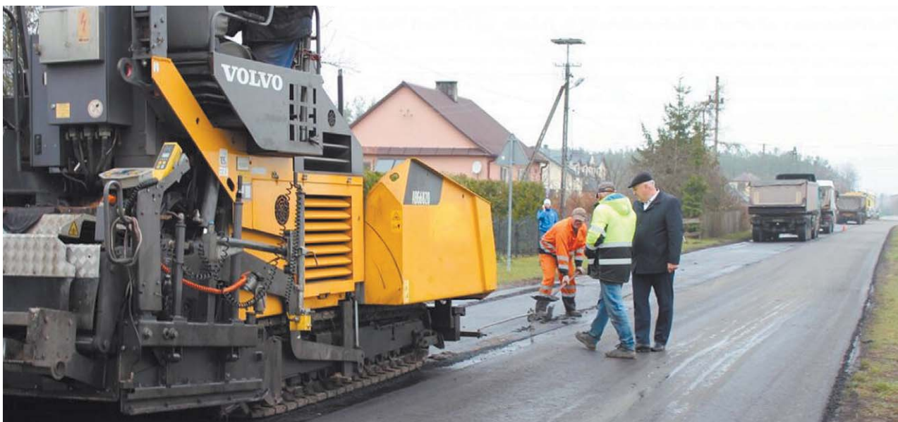
W ubiegłym roku w remoncie był odcinek „nadbużanki” z Kodnia do miejscowości Szostaki
