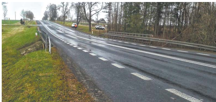
Most przejdzie gruntowną przebudowę
