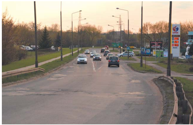
Przebudowa Rejowieckiej opóźnia się
