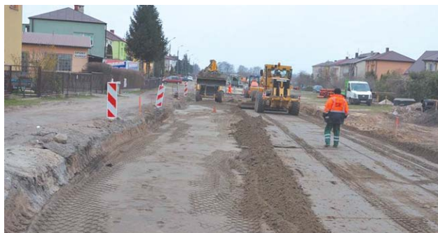
Roboty trwają na całym odcinku drogi, wykonywana jest kanalizacja burzowa i podbudowa pod nową nawierzchnię
