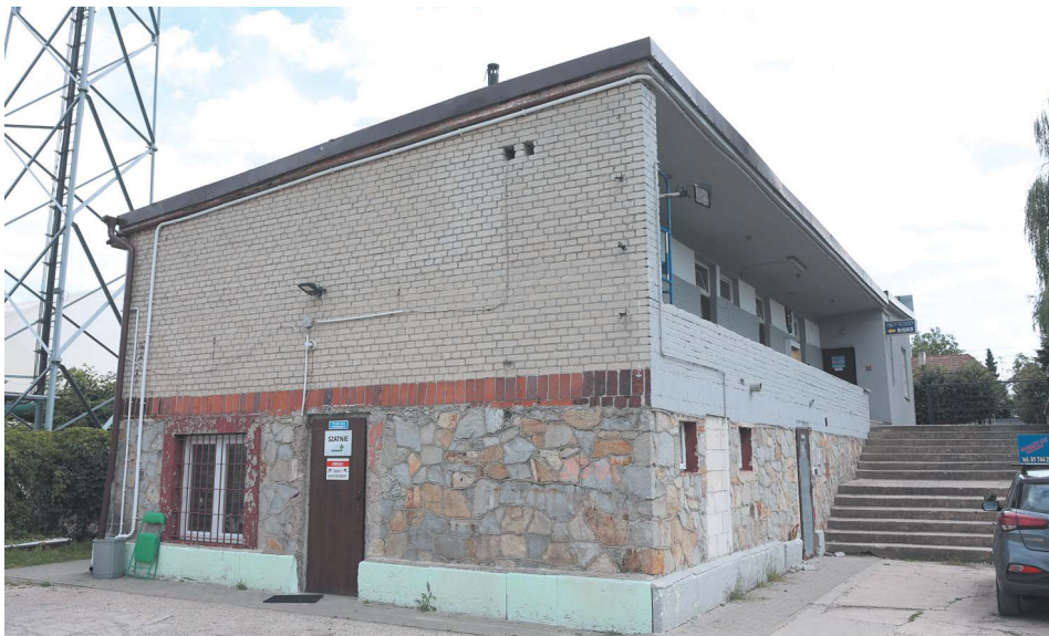
Istniejący budynek ma być wyremontowany, obok ma być dobudowana nowa część
