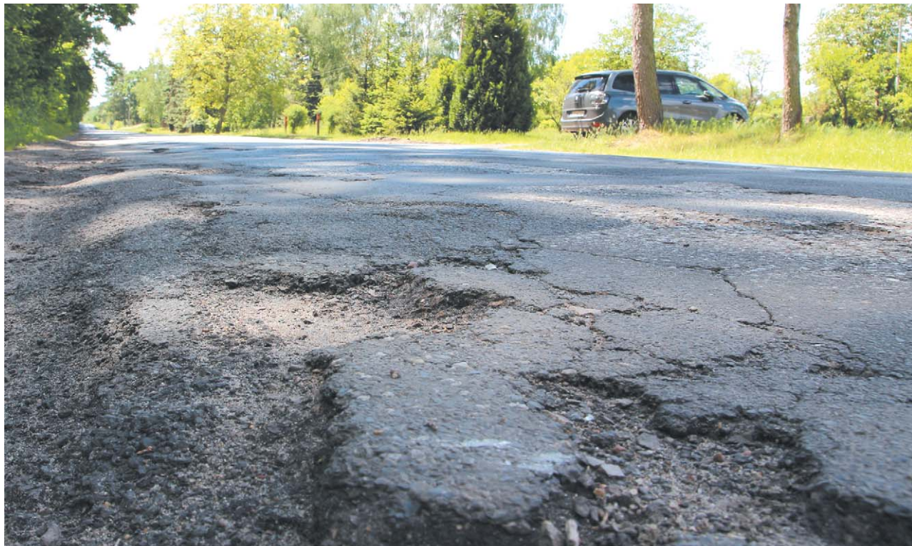
Trasa z Góry Puławskiej do Janowca będzie remontowana w dwóch etapach. Do połowy przyszłego roku gotowy ma być jej powiatowy odcinek (na zdjęciu). Na zajęcie się fragmentem wojewódzkim zaczekamy do roku 2025
