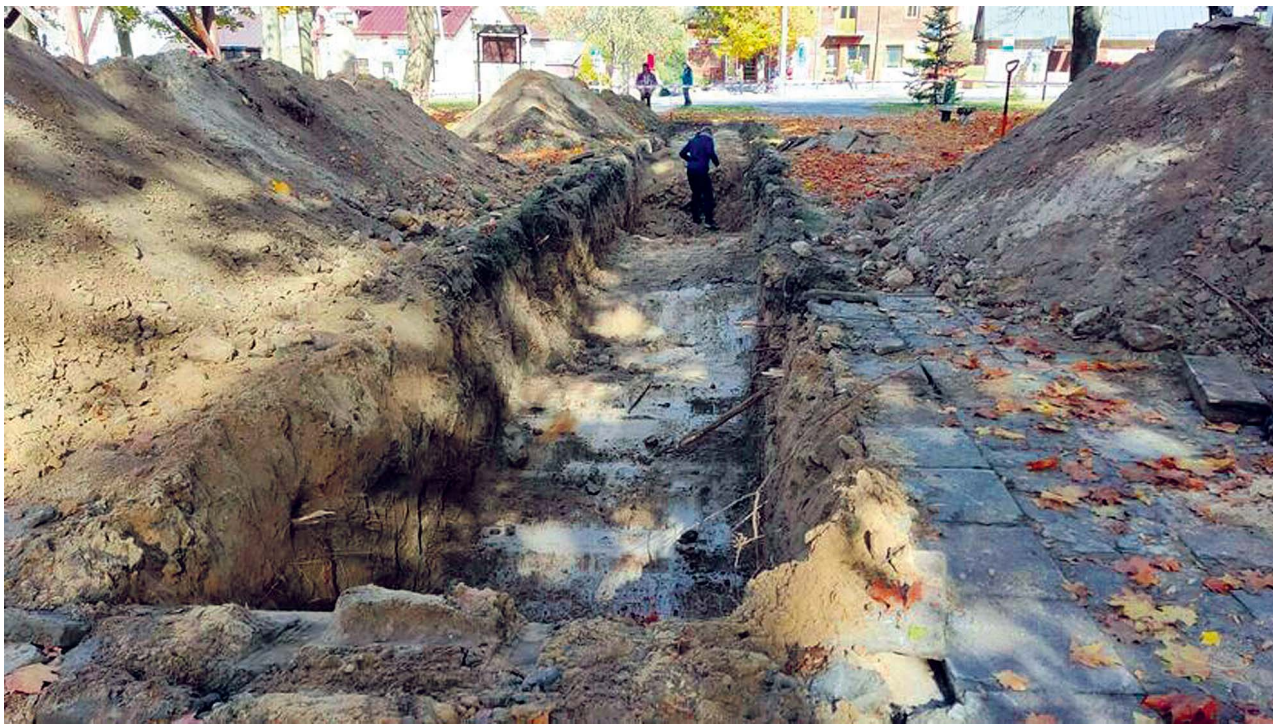
Po badaniach, jakie przeprowadzono jesienią, fundamenty dawnego ratusza zostały zasypane. Ich zarys ma zostać odwzorowany w ramach planowanej rewitalizacji rynku
