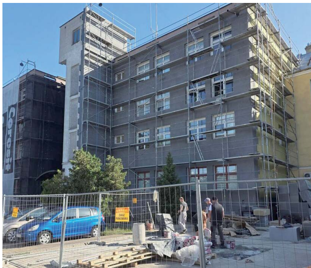
Trwają prace związane z remontem budynków Urzędu Miasta. Obecnie wykonywane jest ocieplenie obiektu przy ul. Lubelskiej 65. Obok – wizualizacja budynku po remoncie. Decyzja o kolorze zostanie podjęta po odkryciu historycznego koloru elewacji
