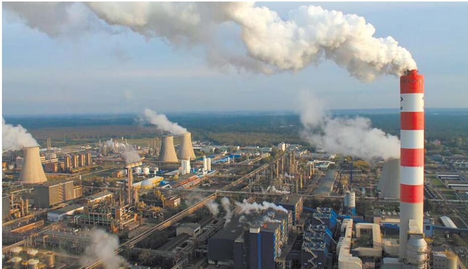
Rozbudowywana elektrociepłownia służy Zakładom Azotowym, a jednocześnie ogrzewa całe miasto. Jej nowy blok energetyczny będzie produkował 100 MW energii elektrycznej i 300 MW ciepła
