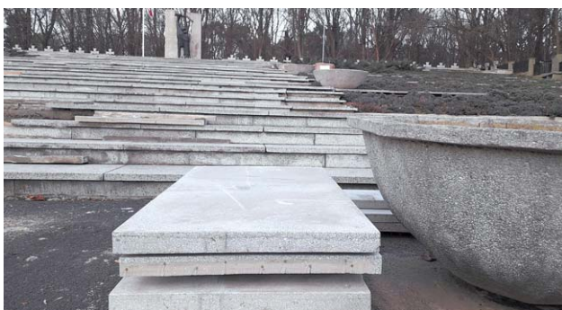
Pracownicy miejskiej spółki Nieruchomości Puławskie starają się ustabilizować ruchome elementy lastrykowych stopni cmentarnych schodów. Wzmacniają i wyrównują ich podbudowę, a uszkodzone elementy wymieniają na nowe
