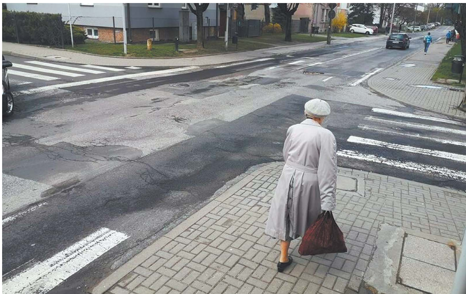
Remontem objęty ma być odcinek ul. Popiełuszki między ul. Poniatowskiego a Legionową. Przewidziano zerwanie z jezdni starego asfaltu i położenie nowego. Asfaltowa nawierzchnia chodników ma być zastąpiona kostką brukową
