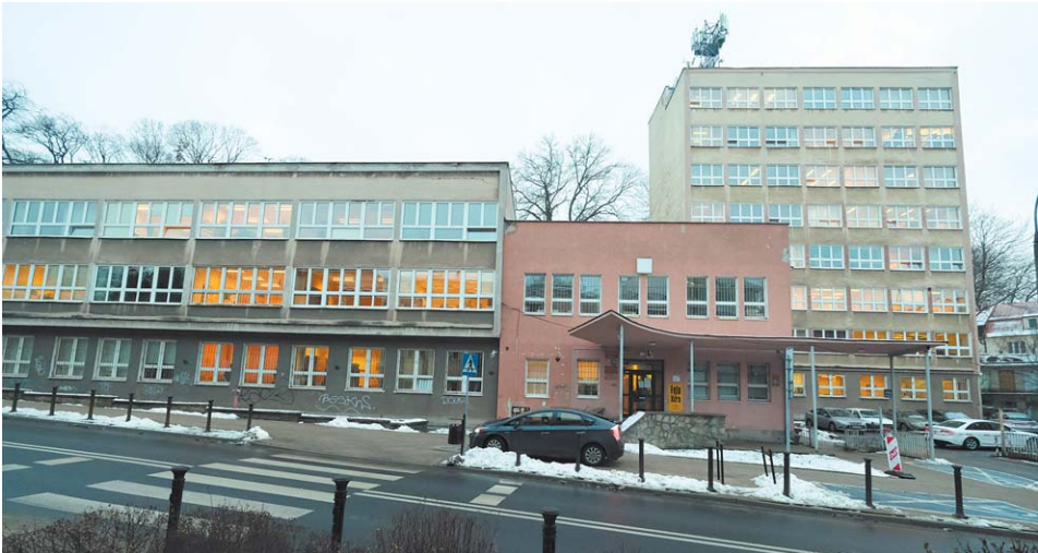
Stary biurowiec ma być zburzony, w tym miejscu ma stanąć nowy
