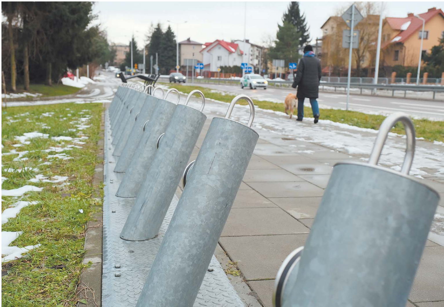
Uszkodzone stojaki miały być naprawiane w ciągu 24 godzin, a za każdą godzinę spóźnienia miasto chciało naliczać 500 zł kary. Teraz daje na naprawę już 48 godzin, a stawka kary za godzinę zwłoki zmniejsza do 50 zł
