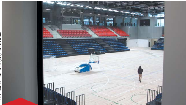
Hala z projektem, wyposażeniem i nadzorem kosztowała ok. 106 mln zł
