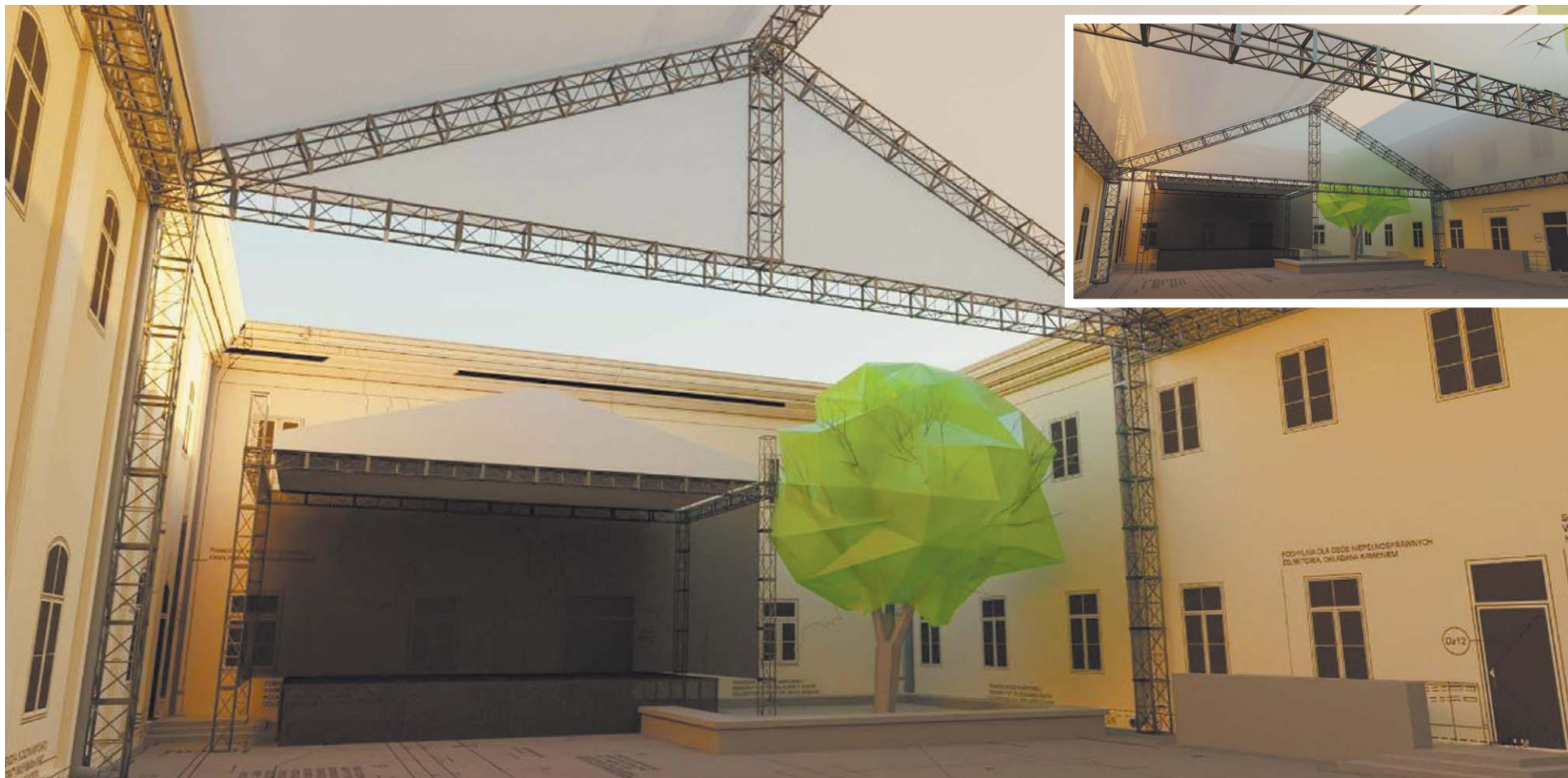
Przy ładnej pogodzie dach będzie znajdował się wyżej, na wypadek deszczu będzie obniżany
