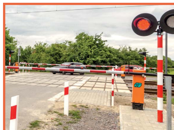
Przejazd kolejowo-drogowy w Trawninkach
