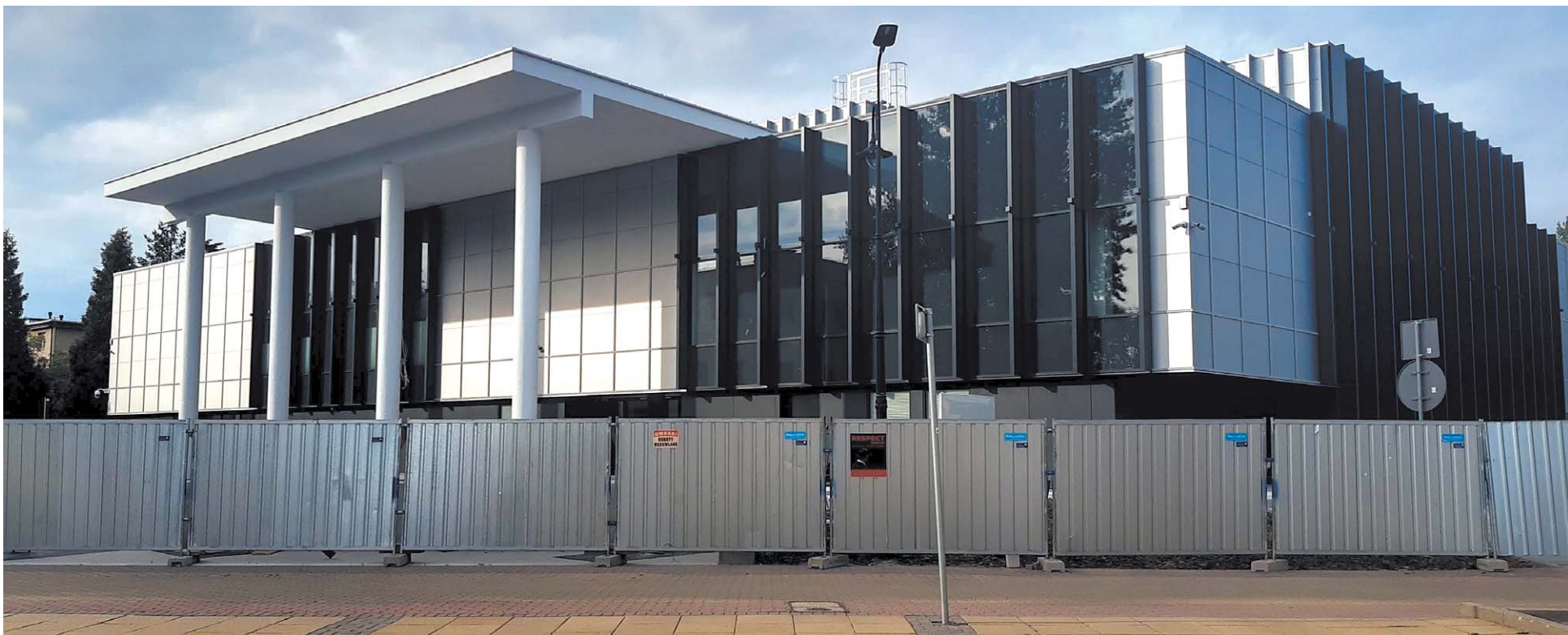
O możliwości demontażu ogrodzenia wykonawcy robót mówili już w czerwcu. Ostatecznie, zgodnie z wolą dyrektora DCH Zbigniewa Śliwińskiego, władze Puław zdecydowały o jego pozostawieniu na kilka kolejnych miesięcy
