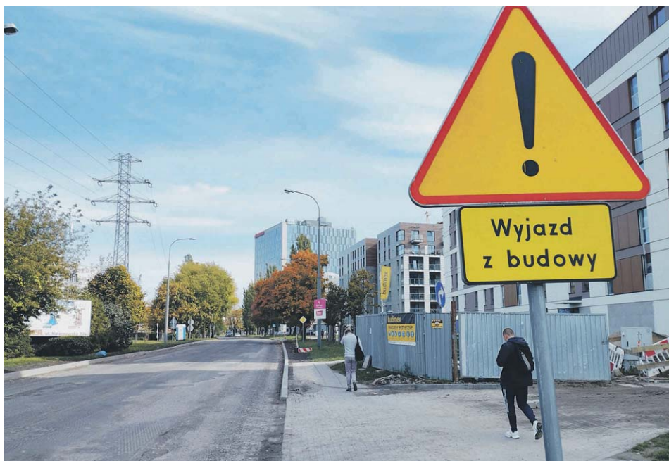
Na czas układania asfaltu, ul. Nałęczowska ma być zamknięta dla ruchu, przynajmniej częściowo
