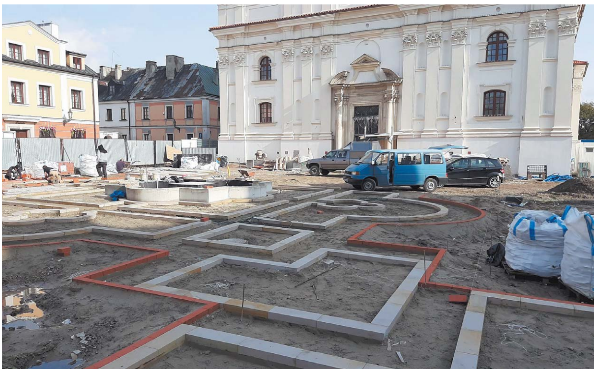
Prace przy brukowaniu skweru przed kościołem od strony zachodniej Starego Miasta
