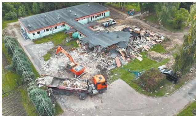
Prace rozbiórkowe idą pełną parą
