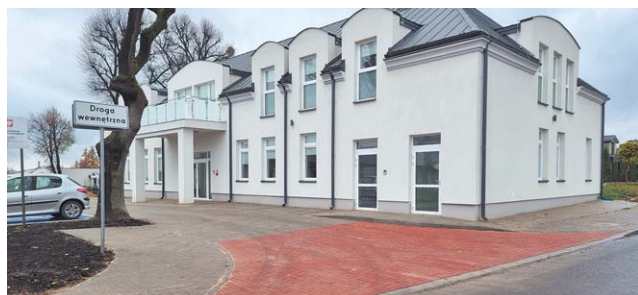
Budowa parkingów i ciągów komunikacyjnych w Jaszczowie kosztowała 614 tys. zł
