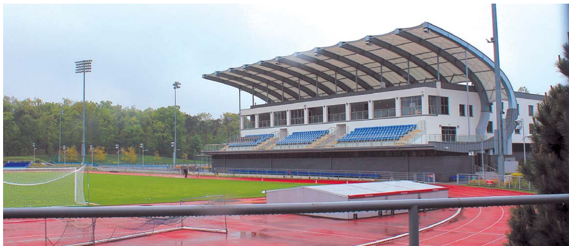
Do nieszczęśliwego wypadku doszło podczas prac konserwacyjnych na stadionie miejskim
