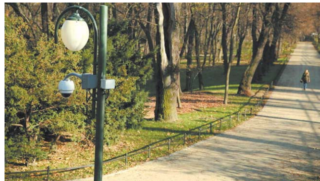
Nowe kamery w Ogrodzie Saskim mają zastąpić te, które zostały zamontowane podczas wielkiego remontu sprzed dziesięciu lat
