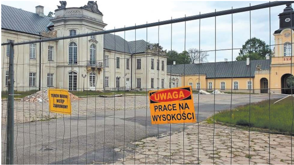
Firma Lubren z Lublina już ogrodziła przypałacowy teren
