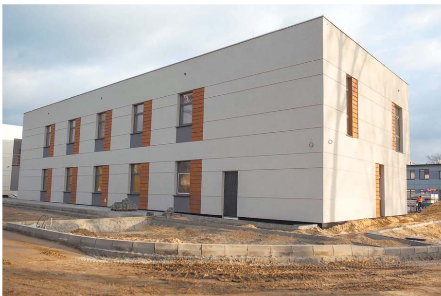
Budowa kolejnych obiektów Centrum Pomocy Osobom z Autyzmem
