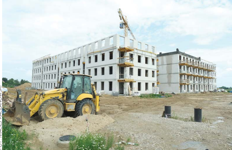
Budowa rządowych czynszówek w Świdniku trwa od jesieni ubiegłego roku
