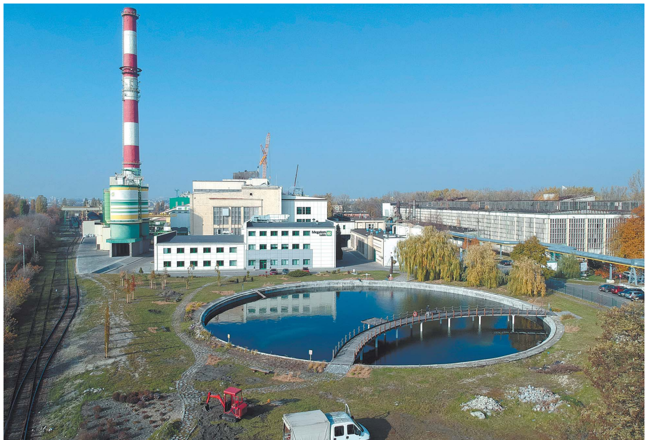
Urząd Miasta zgodził się właśnie na kolejną inwestycję w elektrociepłowni przy Mełgiewskiej
