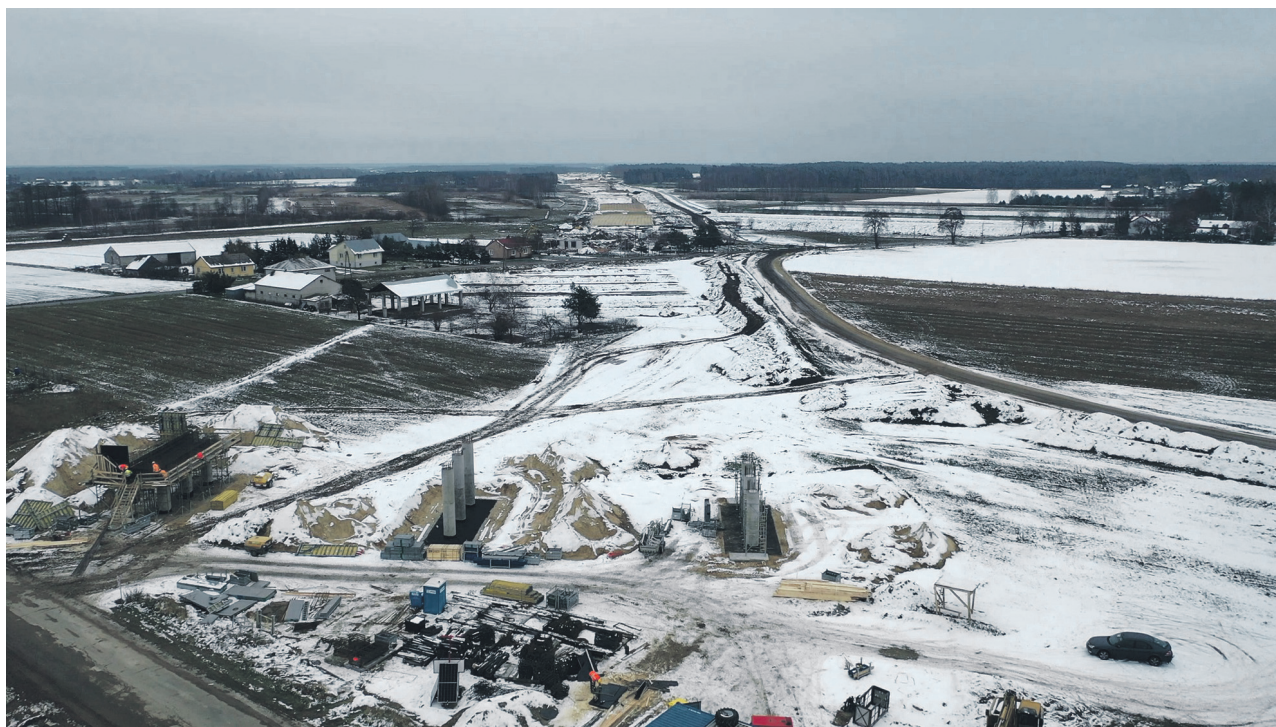
Postępy budowy A2 na odcinku Swory-Biała Podlaska
