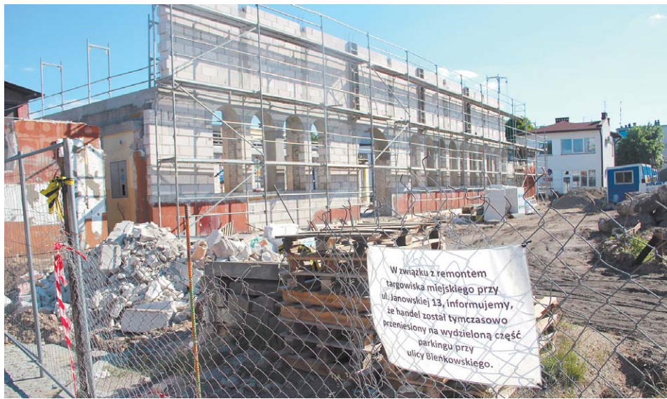
Z powodu remontu „babskiego rynku” kupcy musieli przenieść się tymczasowo na plac przy u. Bienkowskiego
