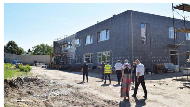
Postępy prac przy kolejnych obiektach centrum
