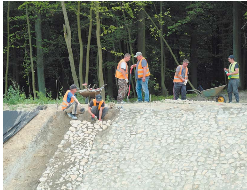
Przygotowywane jest dodatkowe zabezpieczenie. Po stronie lasu, zbocze brukowane jest kamieniami
