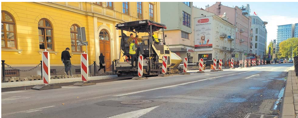
Drogowcy planują rozebrać połowę jezdni służącą do wjazdu na skrzyżowanie z Lipową i Al. Racławickimi
