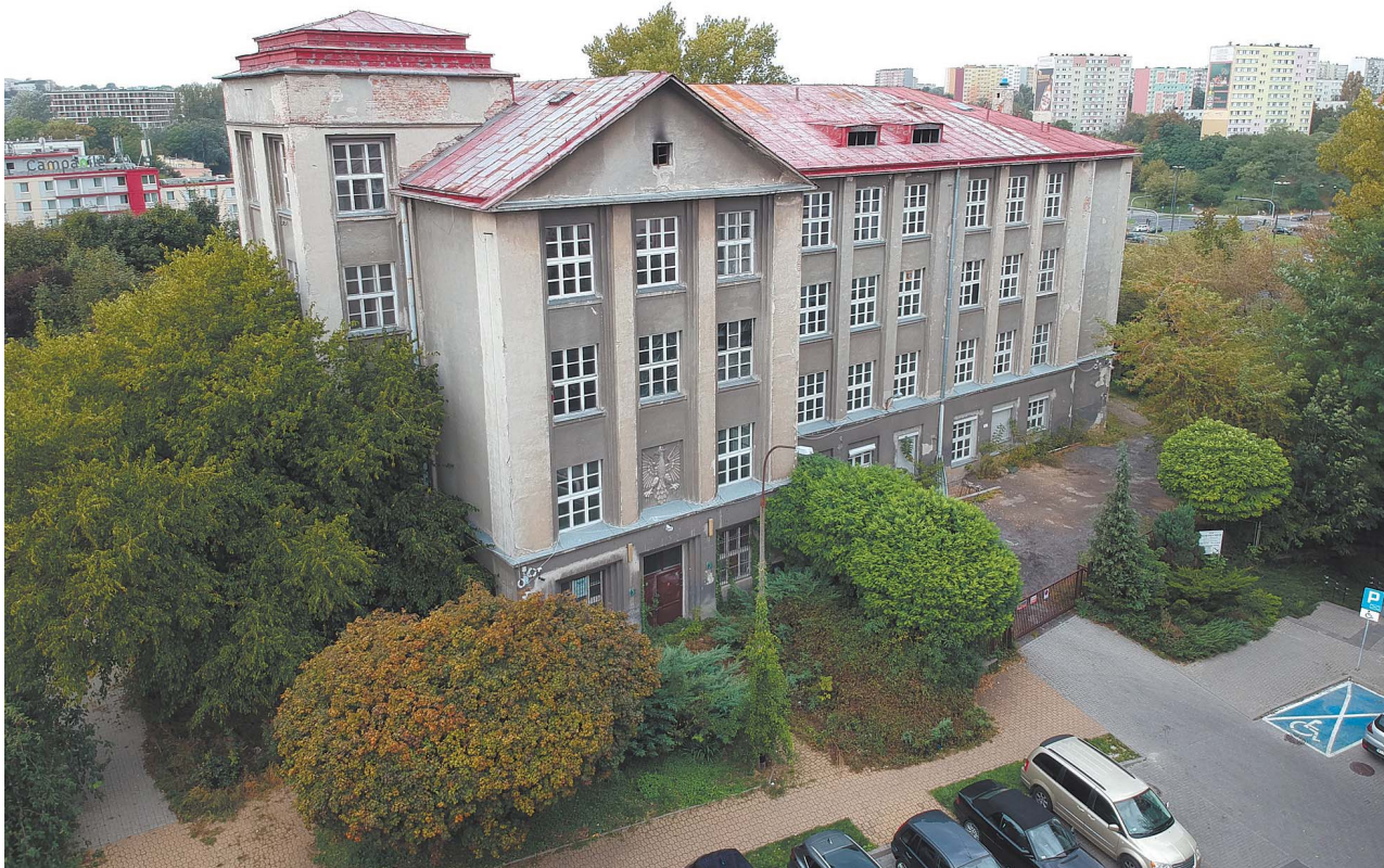
W budynku dawnej mają powstać 53 mieszkania
