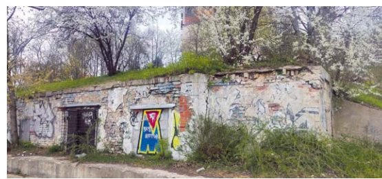
Pozostałości starej lodowni przy ulicy Północnej
