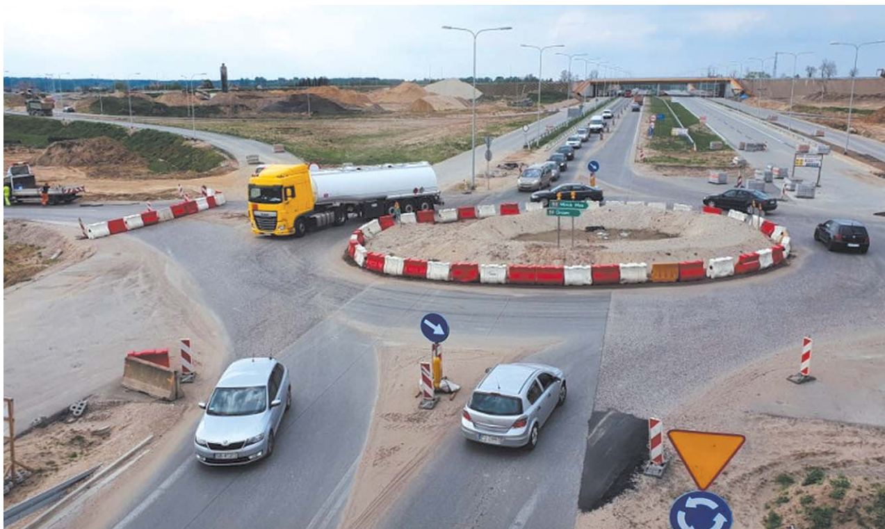
Prowizoryczne rondo w Kołbieli. W głębi – wiadukt na DK 50
