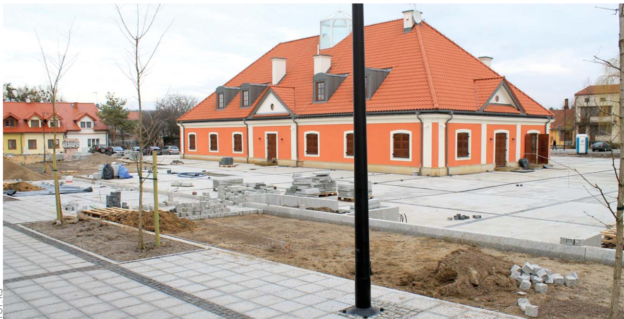
Obecnie trwa drugi etap przebudowy rynku w Końskowoli, czyli budowa placu
