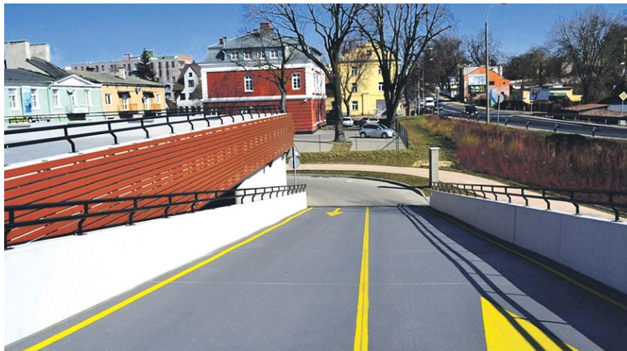
Według zapewnień puławskich urzędników, naprawa zlikwidowała problem przeciekania, a wykonawca robót dał miastu kilkuletnią gwarancję
