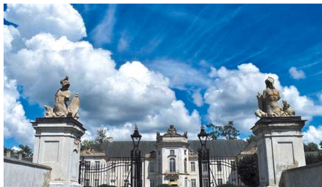
Przetarg na remont pałacu Potockich wygrała firma Lubren z Lublina
