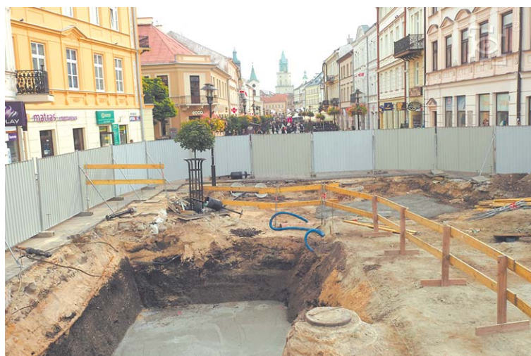
Umowy na prace przy tzw. oknie czasu, czyli komorze wystawowej wbudowanej w bruk koło hotelu Europa są na liście budzących wątpliwości kontrolerów
