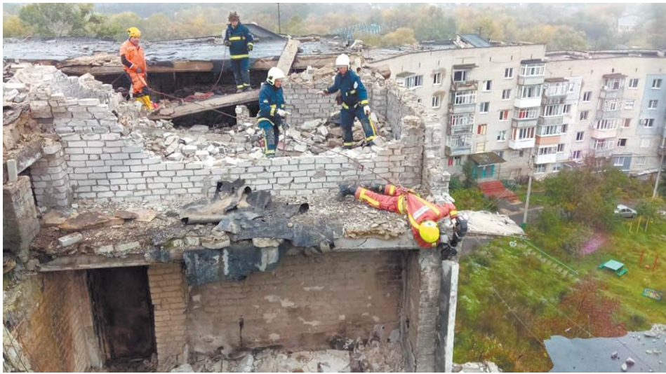
Izium po rosyjskim ostrzale. Ukraińscy ratownicy pracują w zniszczonym 5-piętrowym budynku mieszkalnym
