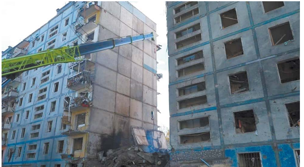
Zaporoże: rozbiórka gruzów 9-piętrowego budynku mieszkalnego
